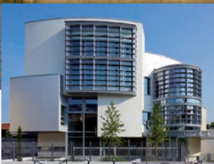
Conservatoire de musique et danse Maurice Ravel de Villemomble Constructeur métallique : Ateliers Mondevilais de Constructions Métalliques (Mondeville - 14)
