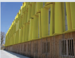
Le TIC - Hub Créatic à Nantes Maître d'ouvrage : Nantes Métropole Aménagement Maître d'œuvre : Cabinet TETRARC Constructeur métallique : EMFA (Les Sorinières - 44)
