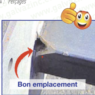
Photos 25 et 26 : Grugeages ou ouvertures dans l'angle
