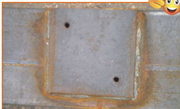
Photo 50 : Trous d'évent et soudure continue
