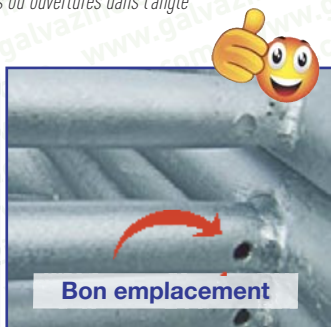
Photos 25 et 26 : Grugeages ou ouvertures dans l'angle
