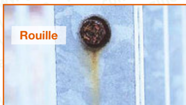
Photo 46 : Boulon électrozingué sur pièce galvanisée, en extérieur
